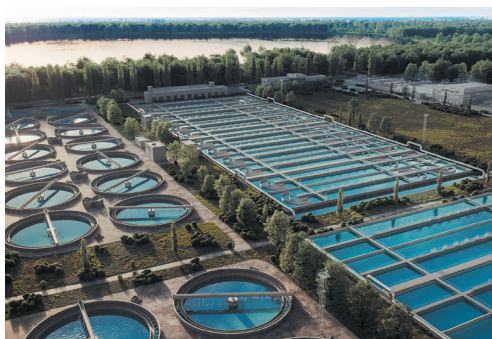
Станція для очищення стічних вод
